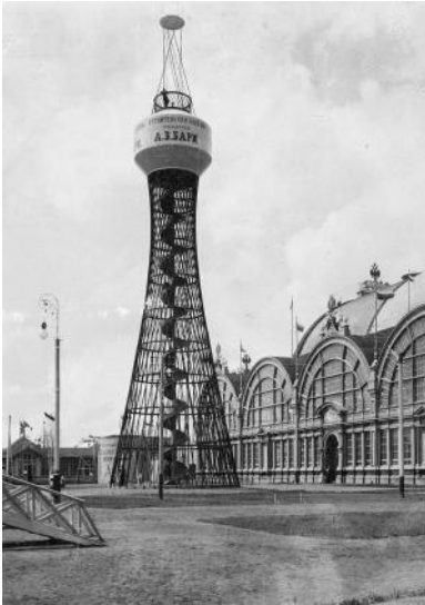
Ryc. 8. Wieża ciśnień projektu Szuchowa (z 1896 r.) w Niżnym Nowgorodzie. © Fot. M.P. Dmitriev (1858–1948). Dostęp online (5.07.2018), domena publiczna
